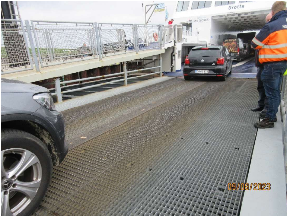
Foto 3: Rampen er nedsænket og "hviler" på underlag. Kun når rampen er løftet og uden last fra trafik bæres rampen af cylindrene.
