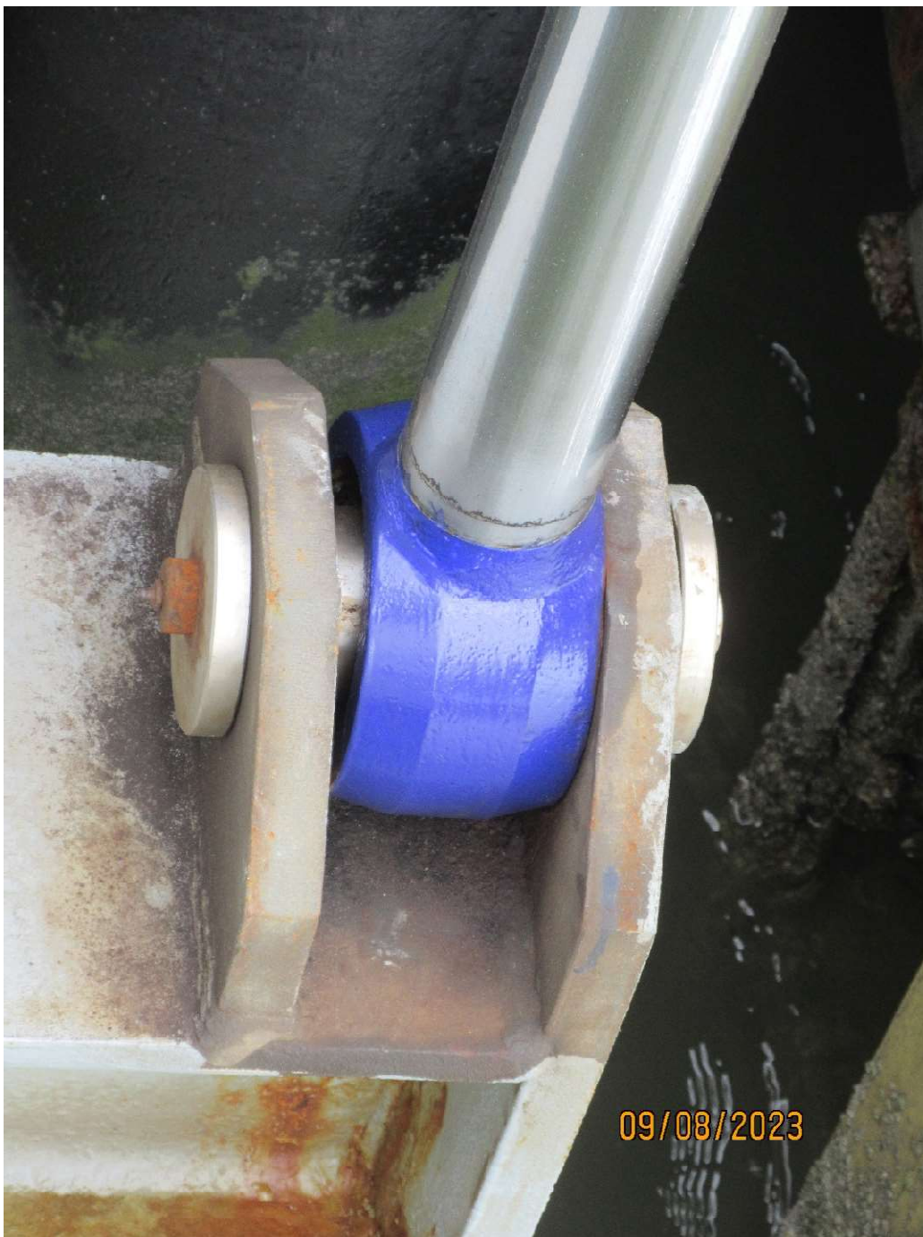
Foto 2: Nyinstalleret cylinder.
