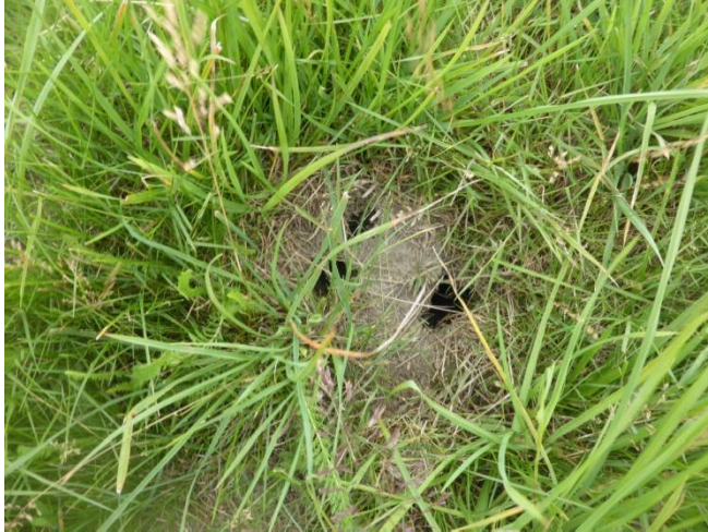
Eksempel på huller (sandsynligvis) efter mosegrise på nord-diget.
